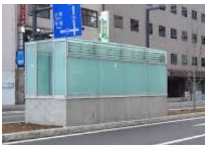
札幌市 地下空スルーホール
